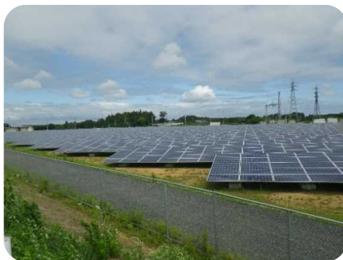
北浦複合団地太陽光発電所
