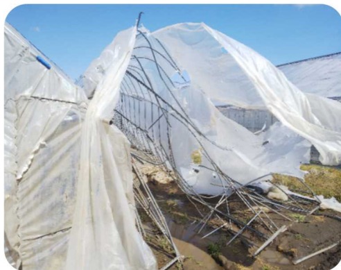
強風による農業ハウスの被害
