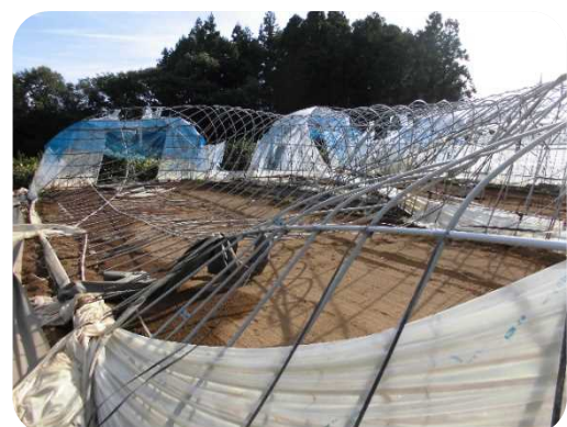
強風による農業ハウスの被害
