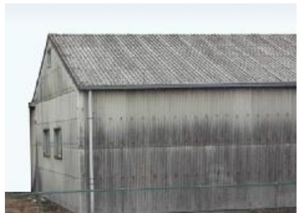
石綿含有スレート波板（屋根・外壁）
