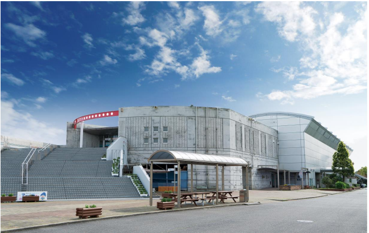
写真④：水の科学館（エントランス）
