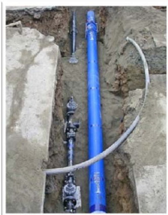
配水ポリエチレン管布設
