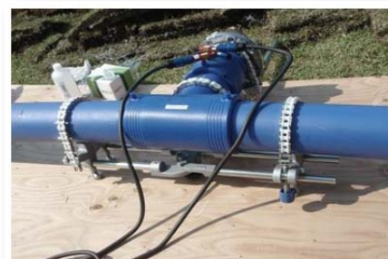
配水ポリエチレン管の融着作業
