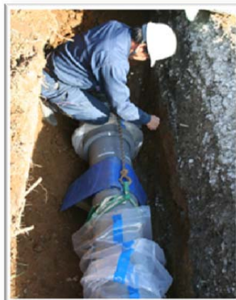
GX形ダクタイル管布設
