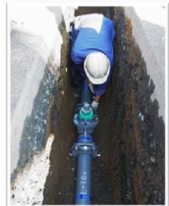
水道用仕切弁設置
