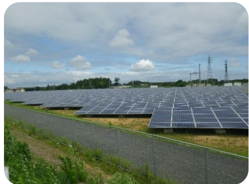
北浦複合団地太陽光発電所
