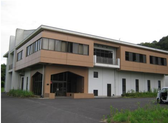
麻生衛生センター
