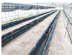
▲試験区栽培槽完成
