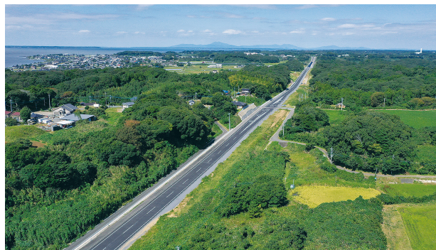
▲ 国道 355 号バイパス（令和 8 年 10 月撮影）
