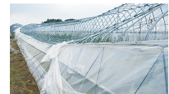
▲ 農業用ハウスの被害の様子
