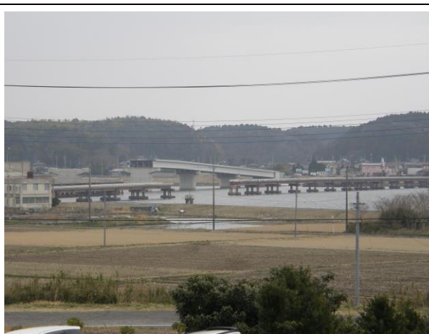
▲中央部分が崩落した鹿行大橋
