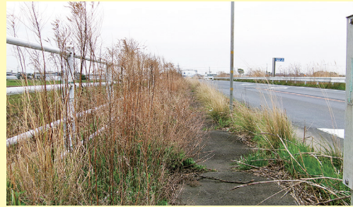
国道355号線の歩道 (R8.4月上旬撮影)
