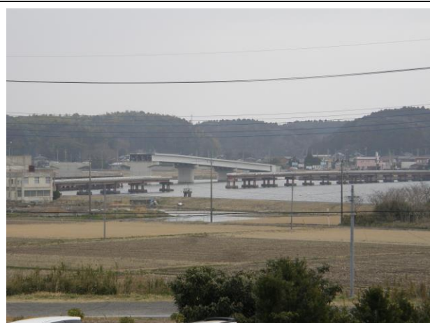
▲中央部分が崩落した鹿行大橋
