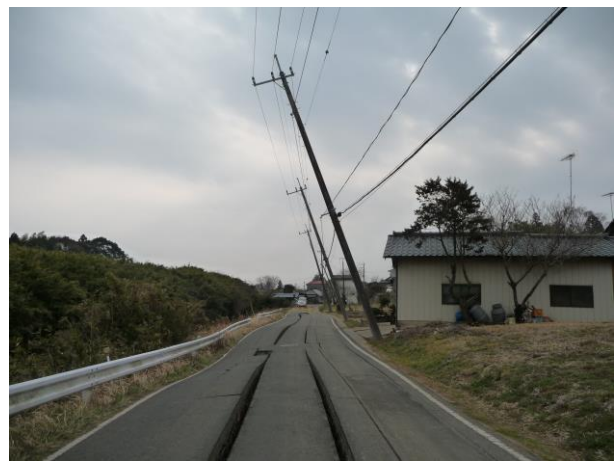
▲市道のひび割れと傾いた電柱
