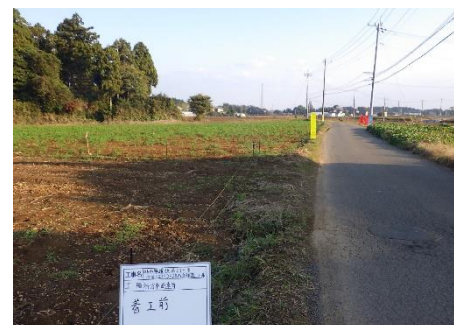
(玉) 53号線 (施工前)
