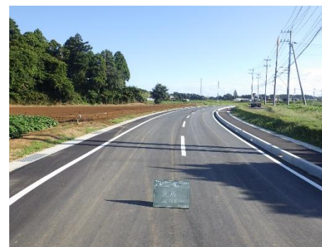
(玉) 53号線 (施工後)
