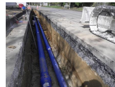
老朽管布設替工事埋設状況
