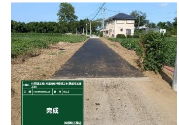
舗装打換工事
