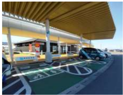
屋根付き優先駐車場 (道の駅グランテラス筑西)
