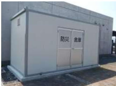
防災備蓄倉庫 (出典:北九州国道事務所HP)
