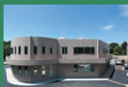
大場内科クリニック新棟
