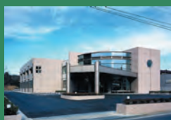
大場内科クリニック本棟
