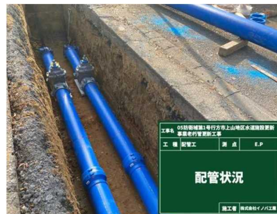
老朽管布設替工事埋設状況
