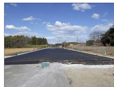
(麻) 1-17号線 (施工後)
