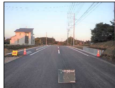
(麻) 2-11号線 (施工後)
