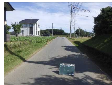
(麻) 2-11号線 (施工前)
