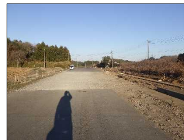
(麻) 1-17号線 (施工前)
