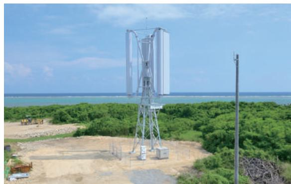
70mの風速に耐える石垣島の縦型風力発電施設
