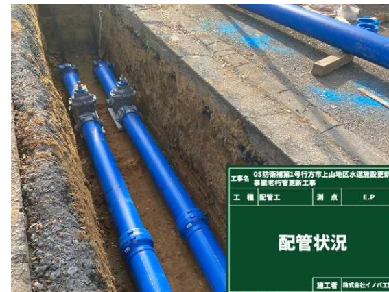
老朽管布設替工事 埋設状況
