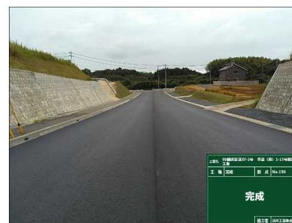
(麻) 1-17号線 (施工後)
