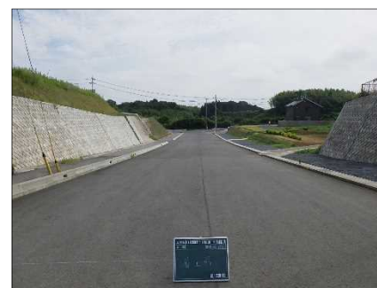
(麻) 1-17号線 (施工前)
