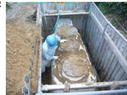
高度処理型浄化槽 (NP型) の設置状況
