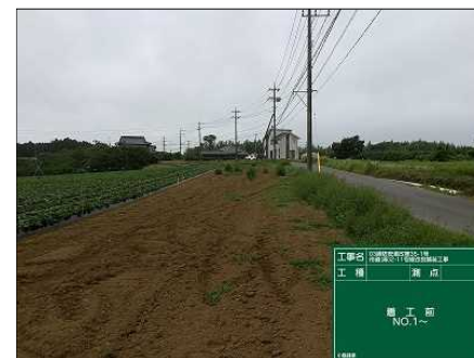
(麻) 2-11号線 (施工前)
