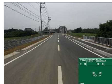
(麻) 2-11号線 (施工後)
