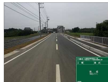
(麻) 2-11号線 (施工後)
