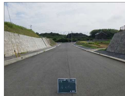
(麻) 1-17号線 (施工前)
