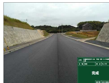
(麻) 1-17号線 (施工後)
