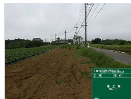
(麻) 2-11号線 (施工前)
