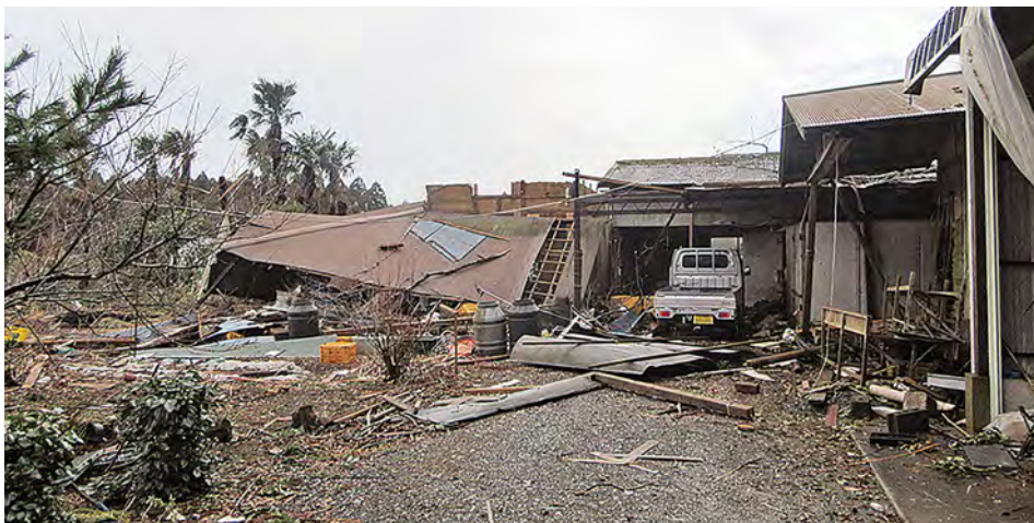
▲平成30年3月に発生した突風被害
