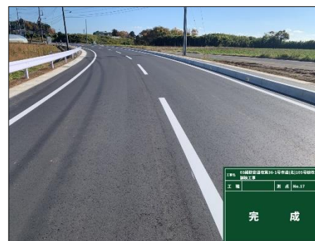
(北)105号線 (施工後)
