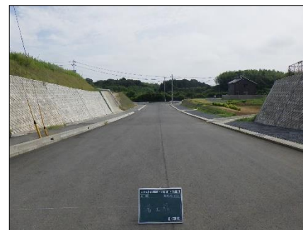
(麻)1-17号線 (施工前)
