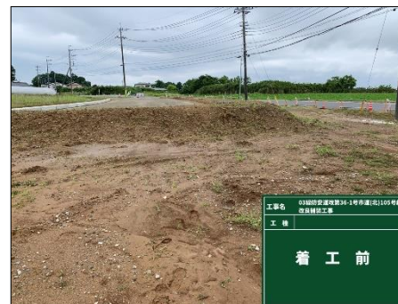
(北)105号線 (施工前)
