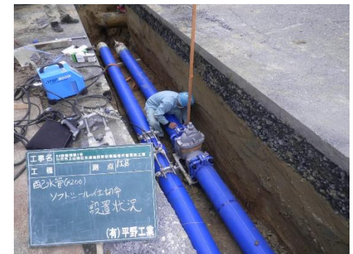
老朽管布設替工事 埋設状況
