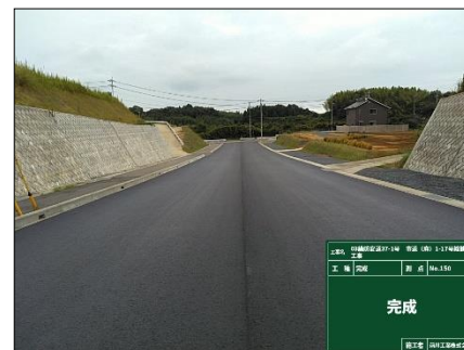
(麻)1-17号線 (施工後)
