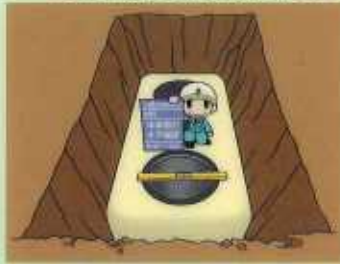
⑨ 本体据付、水平確認
