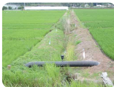
農業用水路(パイプライン)と農業用排水路
