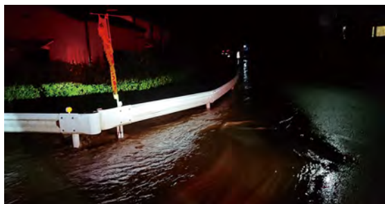
市内での冠水箇所
