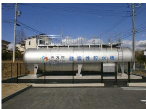
【耐震性貯水槽】
