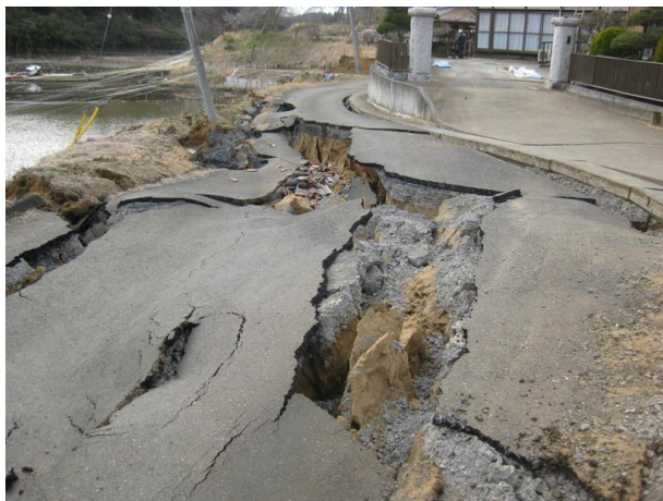
▲崩落した市道
