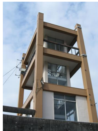
▲柱が圧壊した市役所庁舎(解体済)
