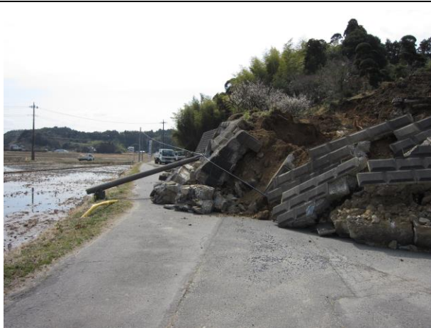
▲崩落した擁(よう)壁
