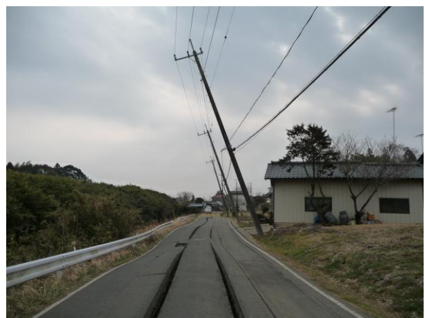
▲市道のひび割れと傾いた電柱
