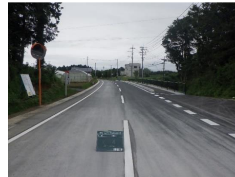
(完成) 現道拡幅
