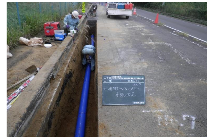
<上山地区老朽管布設替工事> PE管理設状況
