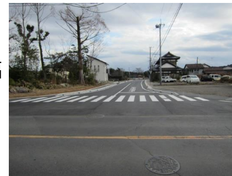
(完成) 現道拡幅
