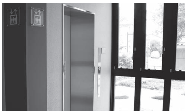
○麻生公民館エレベーターの設置 ※公民館管理事業 ・麻生公民館改修工事 (25,900,000 円)
