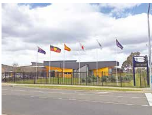
ビクトリア州立ウィンダムセントラルカレッジ
