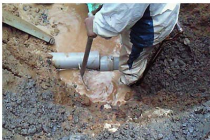
TS 形塩化ビニル管の漏水・復旧作業
