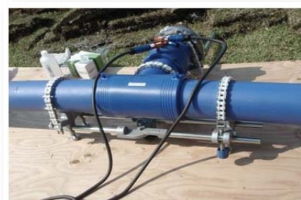
配水ポリエチレン管の融着作業
