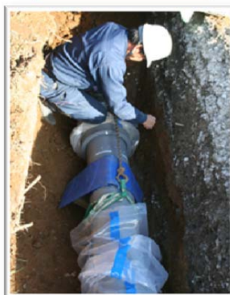
GX形ダクタイル管布設
