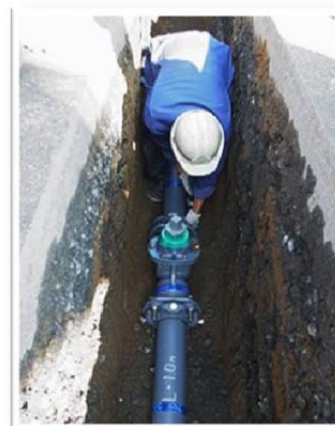
水道用仕切弁設置
