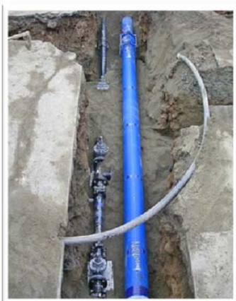
配水ポリエチレン管布設
