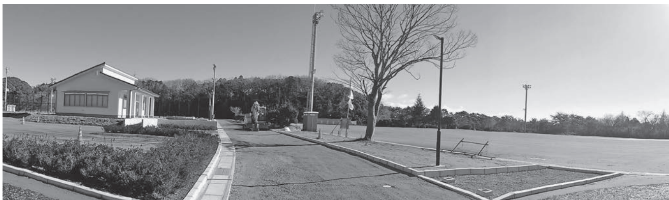
管理棟と多目的広場
