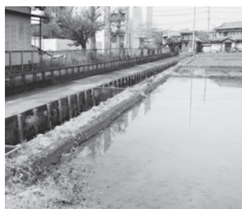
麻生公民館脇排水路
