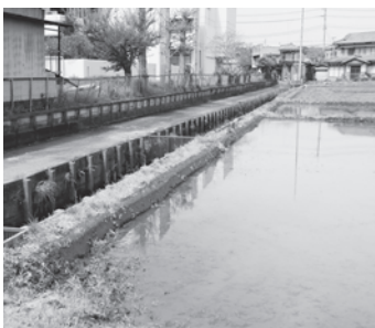
麻生公民館脇排水路
