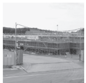
建設中の北浦地区統合小学校
