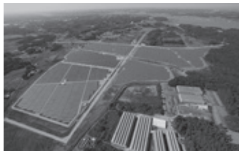
▲北浦複合団地太陽光発電所
