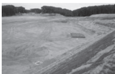
▲北浦統合小学校造成工事
