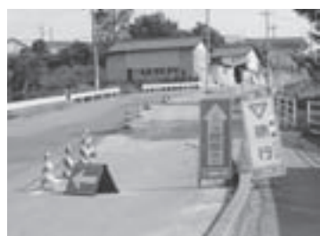
被災した通学路（玉造地区）
