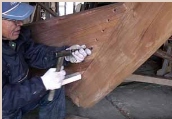
和釘の埋め込み
