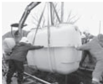
埋設される高度処理型浄化槽
