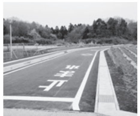
国からの交付金で新設した道路（芹沢地内）
