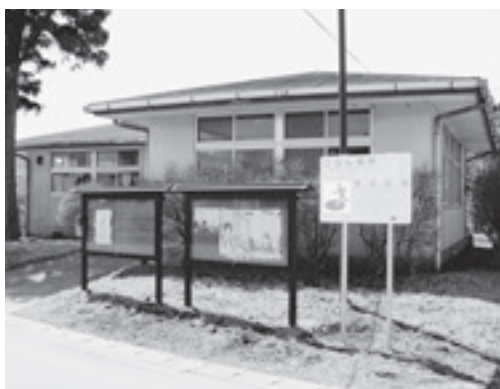
耐震診断等が必要である要地区館
