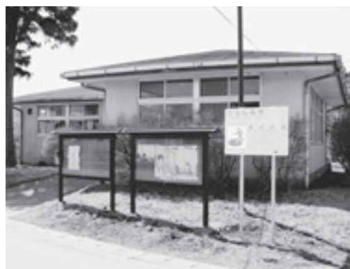
耐震診断等が必要である要地区館
