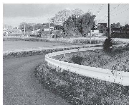
市道3057号線 S字路の箇所
