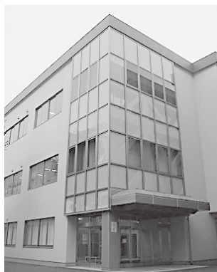
裁判員裁判棟の外観
