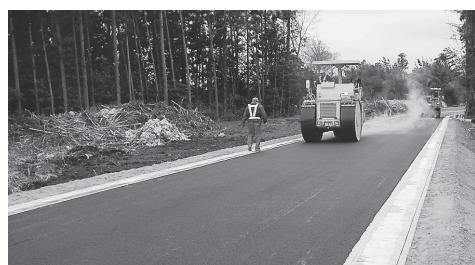
道路も順次整備しています
