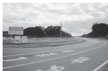
インフラ整備が進められている北浦複合団地
