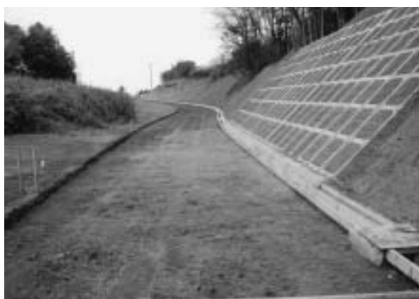
道路改良を進めています（手賀北部）
