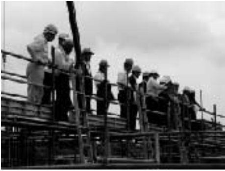
玉造中学校校舎改築工事現場
