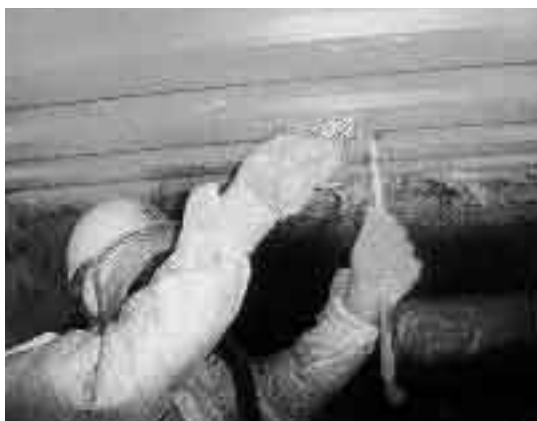
アスベスト除去作業状況（麻生公民館）
