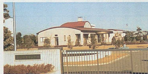
H7 玉造浄化センター
