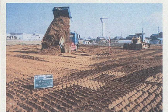
工事が進む農村公園
