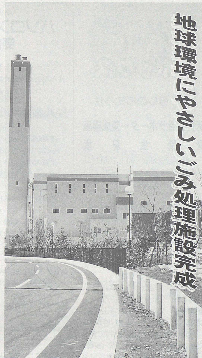
完成した環境美化センター (ごみ処理施設・リサイクルプラザ・管理棟等)
