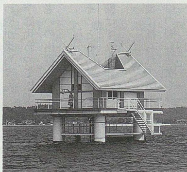
釜谷沖水質監視所
